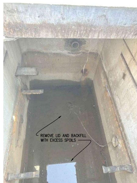
11 9'x5'x6' EXISTING SUBSTATION VAULT SCALE: N.T.S.
