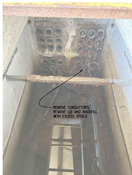
06 9'x5'x6' VAULT INSIDE METAL SHED SCALE: N.T.S.
