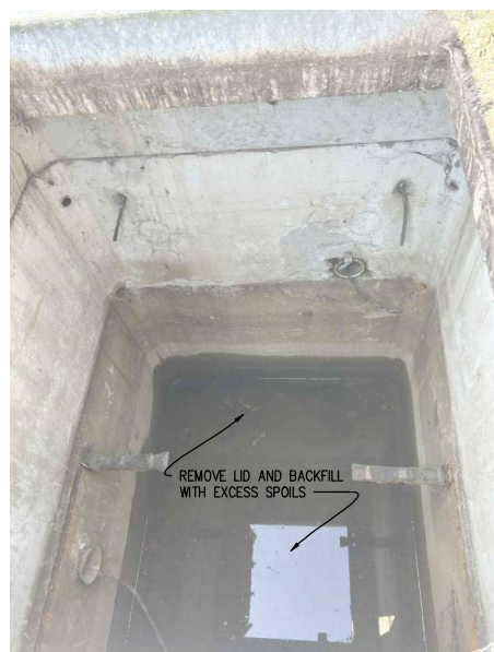
10 9'x5'x6' EXISTING SUBSTATION VAULT SCALE: N.T.S.
